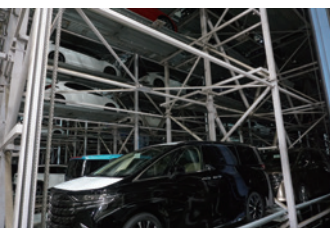
ラック式自動倉庫内部。
