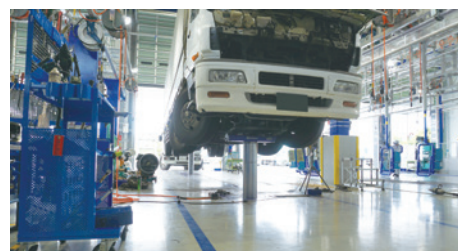
車検整備用の 2 柱リフト FTW30RC を 3 基導入。メカニックの導線を重視し、必要工具を手元に配置。
