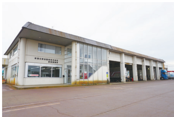
長岡営業所全景。整備工場は手前側3ストールまでが一般整備、その奥の2ストールが車検整備のビット。一番奥は旧検査ライン。
