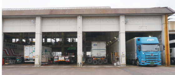
旧検査ラインは現在、電子制御装置点検整備作業場として使用(建物右側)。
