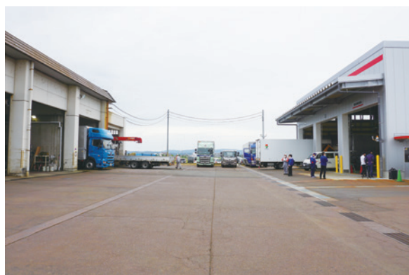
従来の整備工場と(左)と新設の車検整備棟(右)
